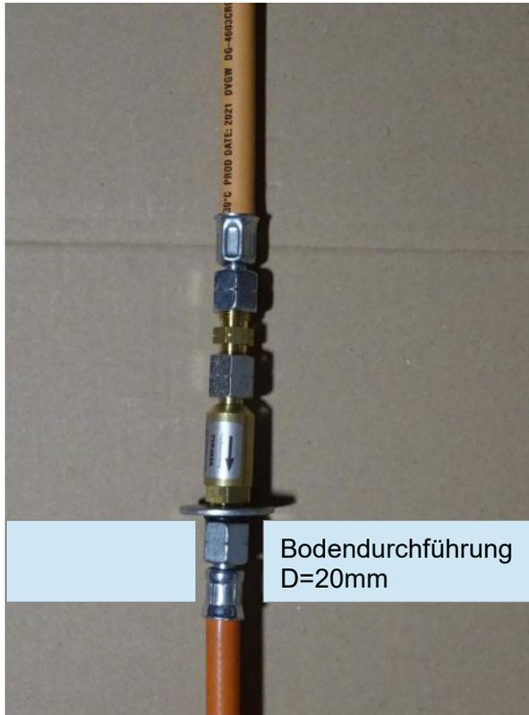
Anschluss mit Adapterschlauch
